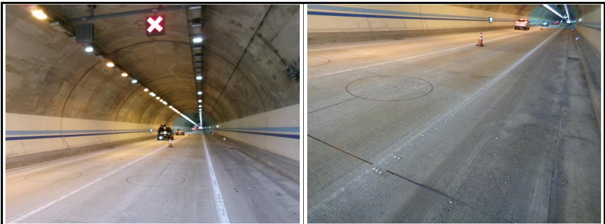
【사진 6.3.11】 포장부 전경
