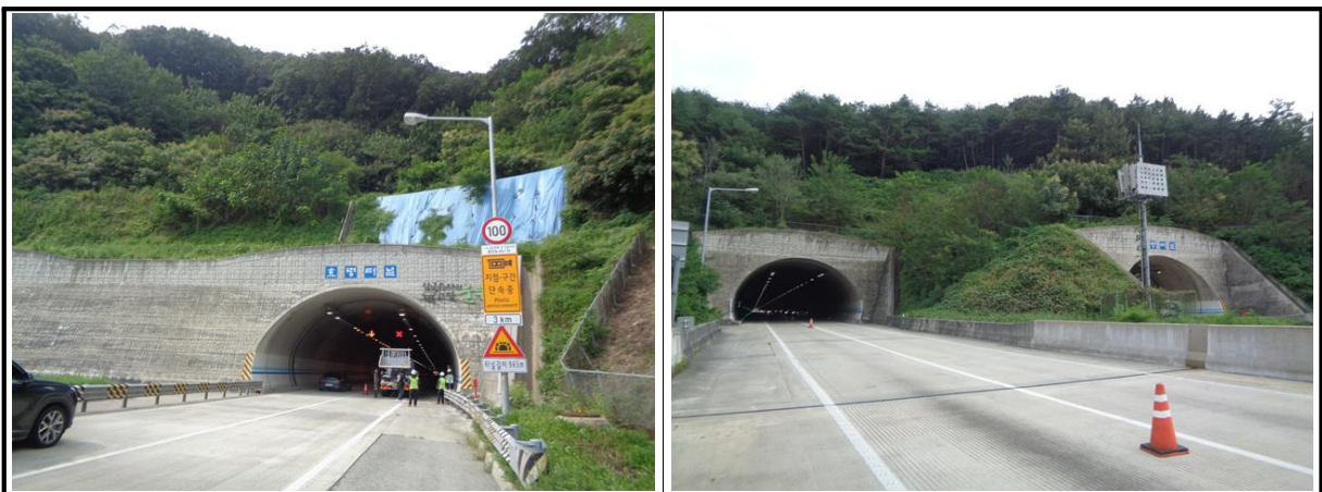
【사진 6.3.7】 사면 전경
