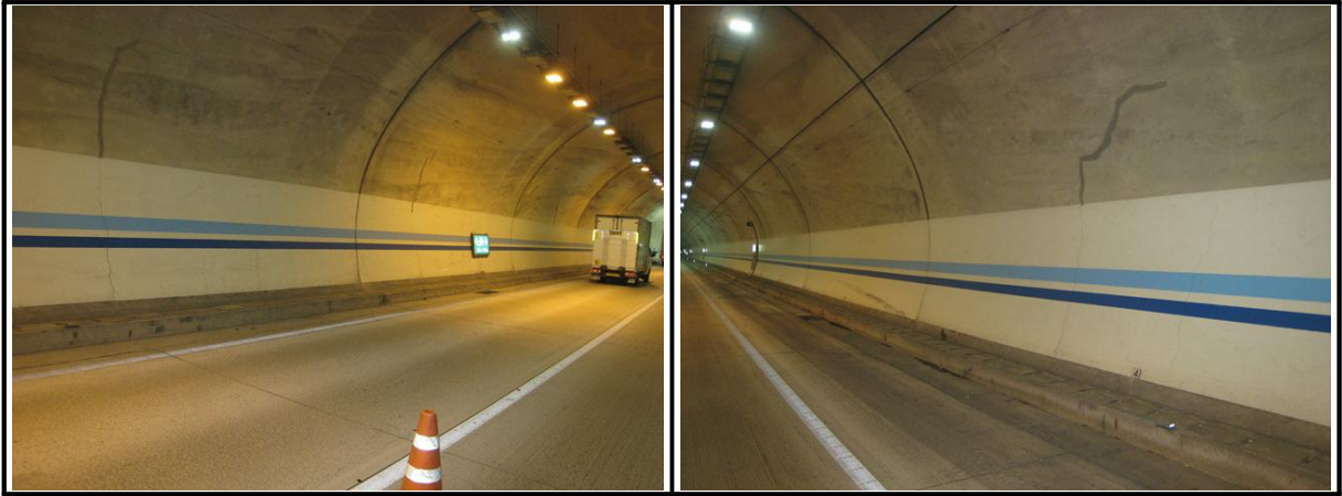
【사진 6.3.17】 라이닝 측벽부 전경
