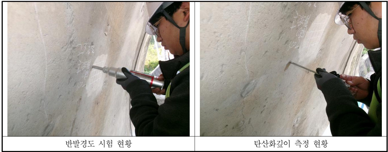
【사진 6.4.1】 콘크리트 내구성조사 현황
