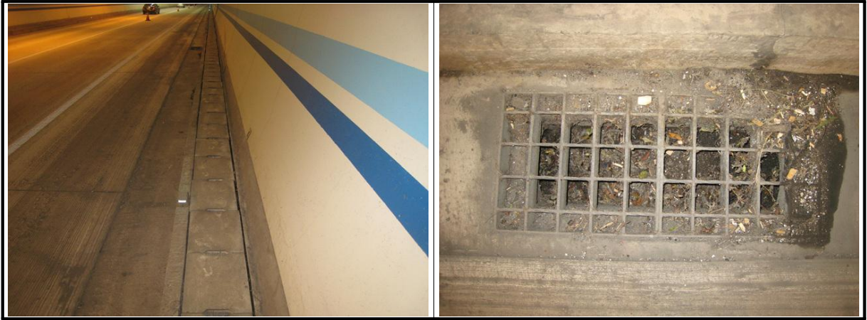
【사진 6.3.23】 공동구 및 배수시설 전경
