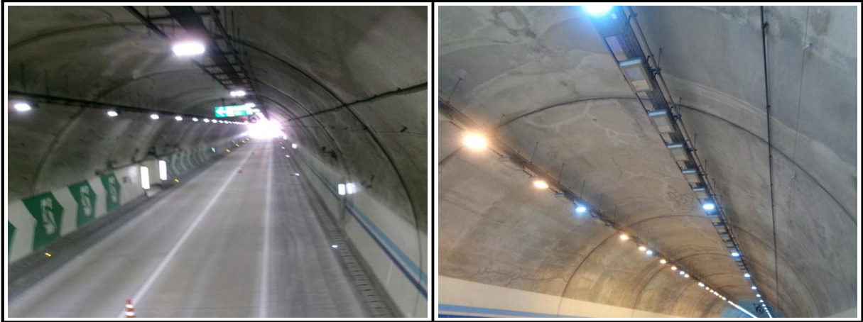
【사진 6.3.1】 라이닝 천단부 전경
