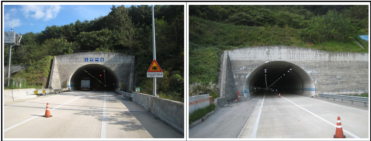
【사진 6.3.19】 갭문 전경
