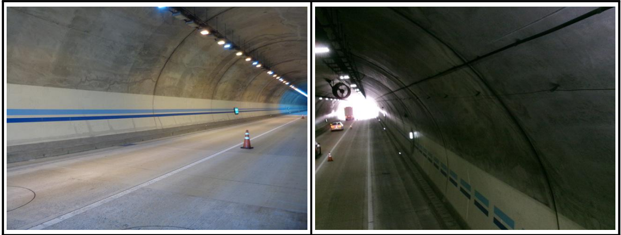
【사진 6.3.3】 라이닝 측벽부 전경
