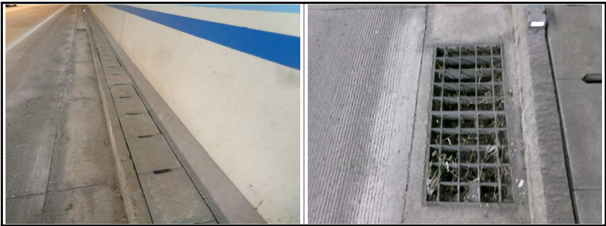
【사진 6.3.9】 공동구 및 배수시설 전경
