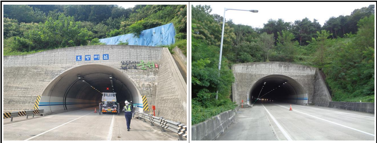
【사진 6.3.5】 갯문 전경
