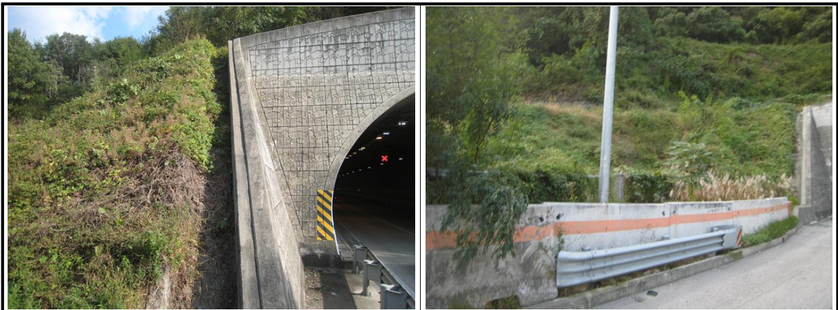
【사진 6.3.21】 사면 전경
