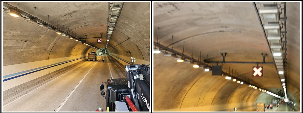
【사진 6.3.15】 라이닝 천단부 전경
